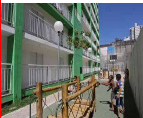
Conjunto Real Parque - Butantã
